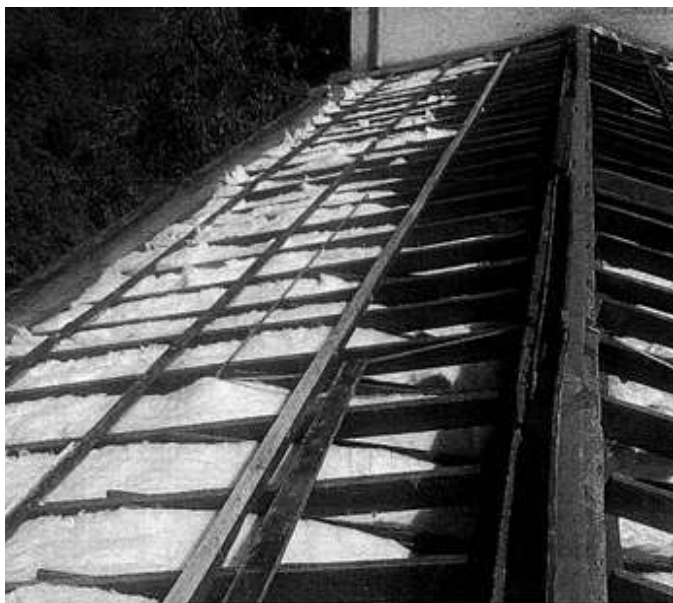
Figura N°35: Cambio techumbre asbesto Liceo Carmela Carvajal
