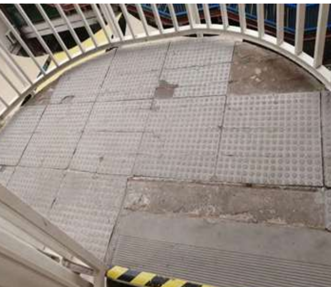
Figura N°25: Escalera Liceo Tajamar
